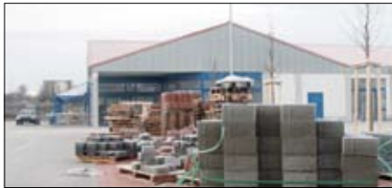
Noch wird am neuen Salbker „Lidl“-Markt gebaut.
